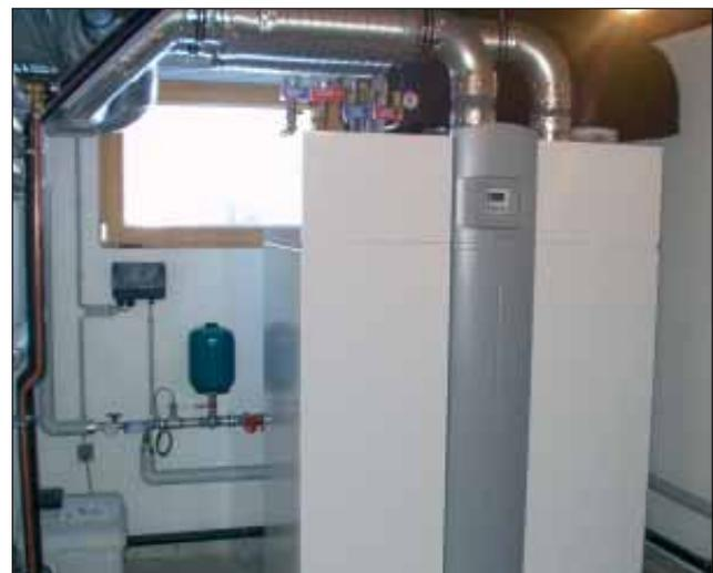
Bild 2. Die Einbindung der Luft/Wasser-Wärmepumpe in die kontrollierte Wohnraumlüftung mittels KNX schafft die Grundlage für sehr günstige Verbrauchsdaten / Figure 2. The integration of the air/water heat pump into the room ventilation controlled via KNX is the basis for the low energy demand
